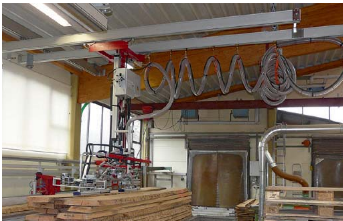
IHF-Jungenthal installierte bei Holz Köhler das Vakuumhebegerät für die Ab stapelung und Zuführung der Hölzer
